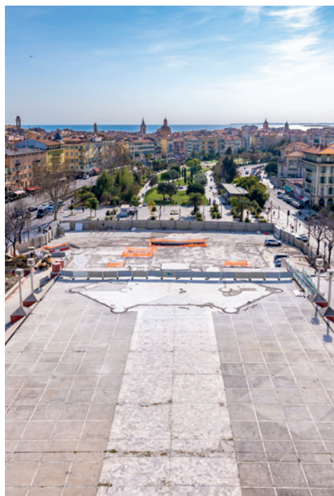
Travaux : Secteur de la Bourgada
